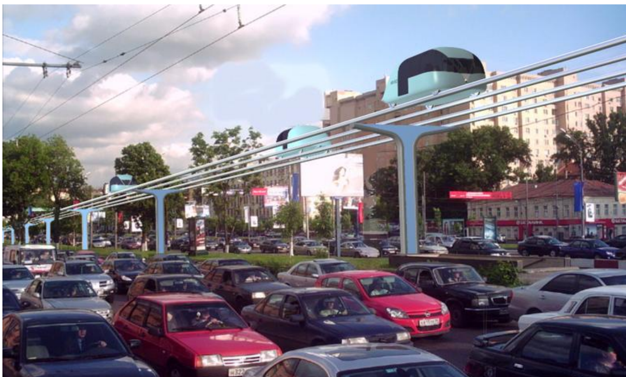
Рис. 3. Двухпутная трасса городского бирельсового СТЮ (скорость до 120 км/час)
